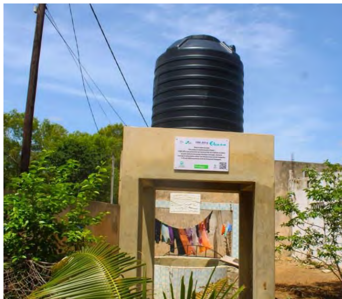
Installation de réservoir et puits à adduction solaire à Soudiane (PADEM – 2025)
