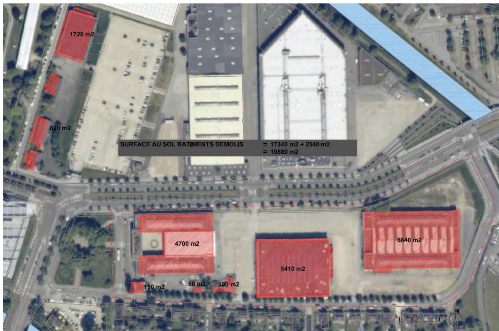
Figure 13 Bâtiments existants démolis
