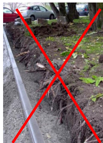
Photo 13 et 14 : Exemples de non-respect des prescriptions : mise à nu du système racinaire / racines sectionnées par arrachements. Impact défavorable sur la viabilité de l'arbre
