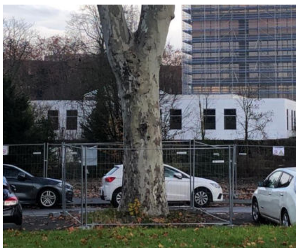
Photo 3 : zone protégée de l'arbre matérialisé dans ce cas par des barrières HERAS
