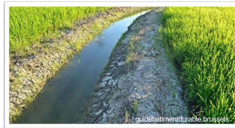
**La noue** permet de capter et de stocker les eaux de pluie de la parcelle. Fossé peu profond, large, végétalisé. L'eau est stockée jusqu'à infiltration ou évaporation.
